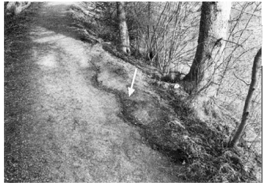
그림 2. 좌: 붕괴 위험성에 대한 모식도, 우: 균열로 붕괴위험이 있는 이자강(Isar)의 제방 (Schaufuss, 2003)
