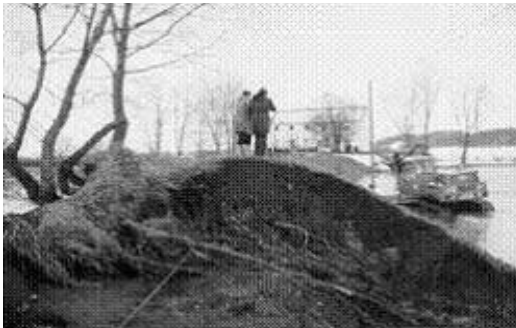
그림 3. 수목이 있는 제방에서의 제방붕괴(사진: Haselsteiner, 2010)
