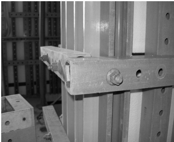
그림 2. FRP 거푸집의 연결 ( http://blog.daum.net/chsung )
