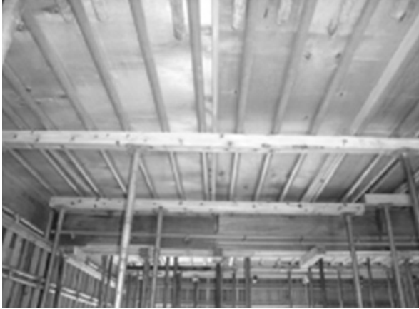
그림 5. FRP를 이용한 거푸집 보강 ( http://blog.daum.net/chsung )
