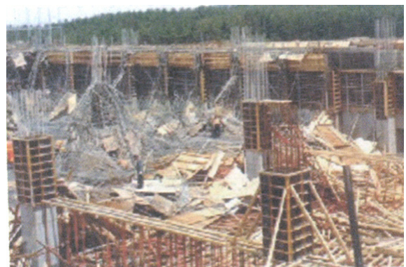
<그림 1> 무리한 공사계획으로 인한 슬래브 붕괴
