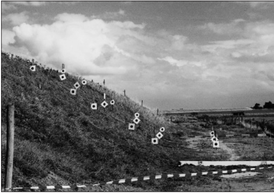
그림 1. 제방의 사면에 설치된 표지판
