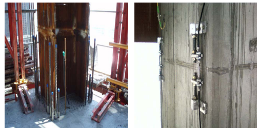
〈그림 4〉 변형률센서 부착 사례
