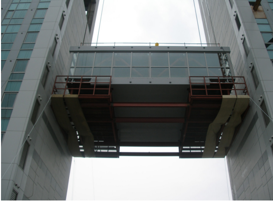
〈그림 11〉 스카й브릿지 리프트업 전경
