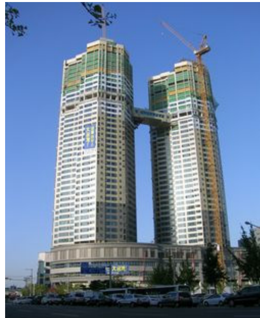
〈그림 1〉 스카이브릿지 시공 전경 대성스카이렉스 울산, 2010
