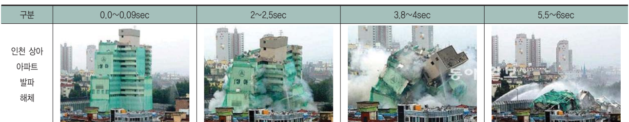
그림 8. 세계 최초 15층 순수벽식구조 고층아파트 발파해체 시험시공 전경 (인천 벽식구조 T자형 상아아파트, 15층, 길이 50m, 높이 45m)
