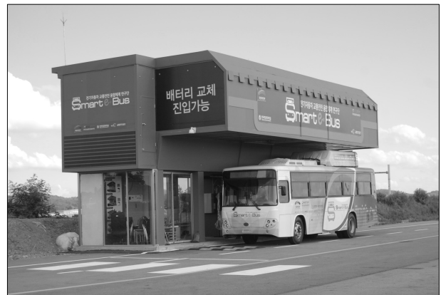
그림 1. QCM/QTPE-BUS 배터리 교환 시스템 Fig 1. QCM/QTPE-BUS Battery Exchange System
