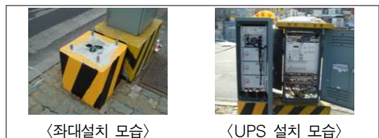
〈그림 1〉 UPS 좌대 및 UPS 설치 〈Fig. 1〉 Installation of the Trial Prototype UPS
