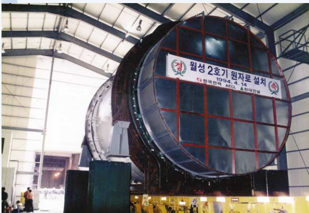
▲ 월성 2호기 원자로 설치
