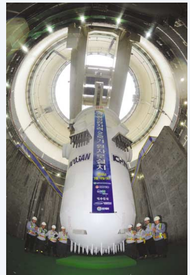
▲ 신월성 2호기 원자로 설치
