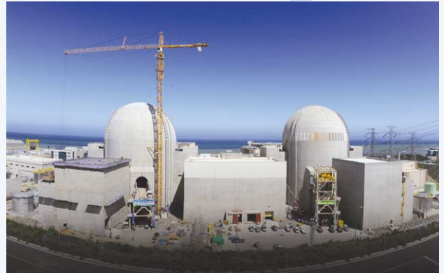
▲ 신월성 1,2호기 건설 전경
