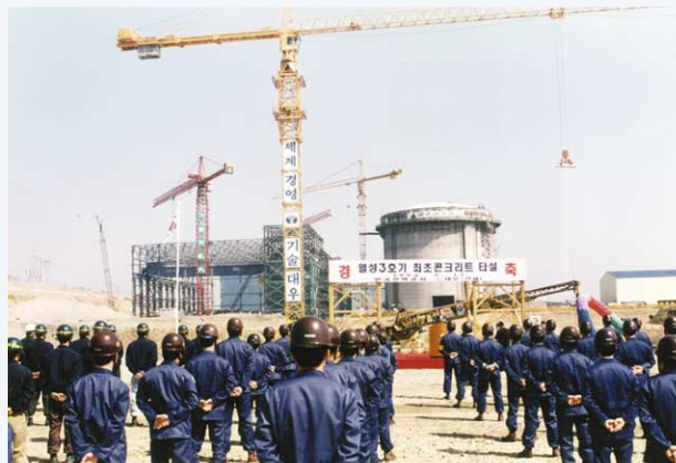
▲ 월성 3호기 최초 콘크리트 타설
