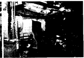
[사진 6] 1층 사무실, 출입구 방향의 연소상황
