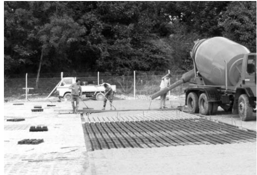
그림 3. 콘크리트 현장 타설
