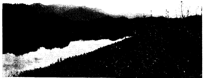
우포늪 대대제방의 시공 후의 장면
