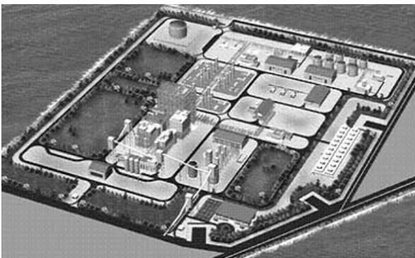
포스코 합성천연가스 플랜트 조감도
