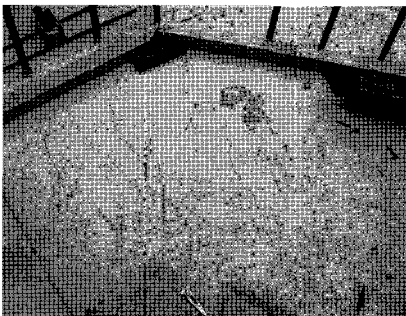
a. 매스 콘크리트 수화열 균열(중심과 표면과의 온도차)
