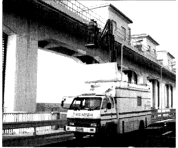
그림 7. 배수갑문 안전진단 전경
