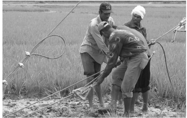
방글라데시 400kV 송전 컨설팅 시공분야 김리현장
