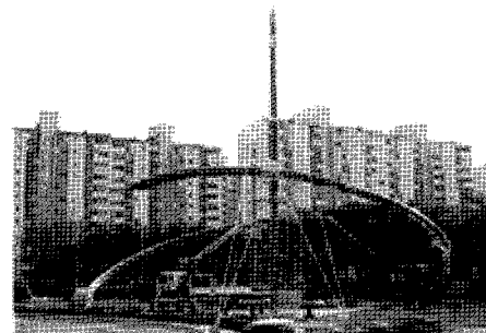
<사진 7> 철골 체결후 지지케이블 설치
