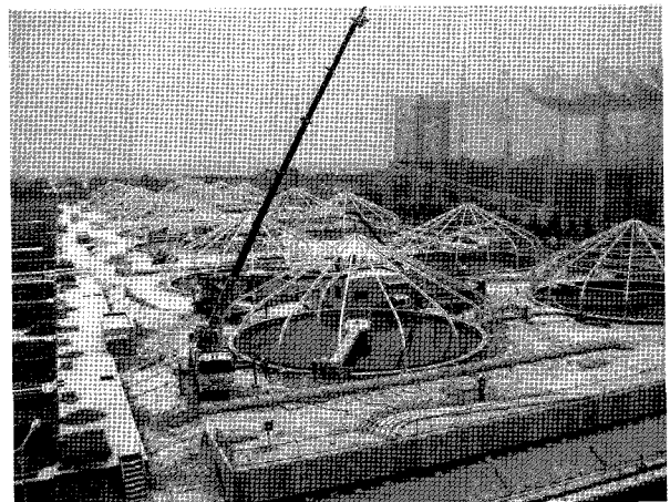
〈그림 21〉 알루미늄 골조 설치 전경
