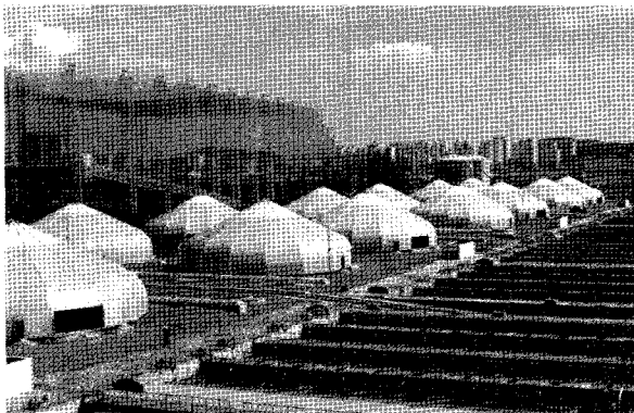
<그림 1> 설치 후 전경사진
