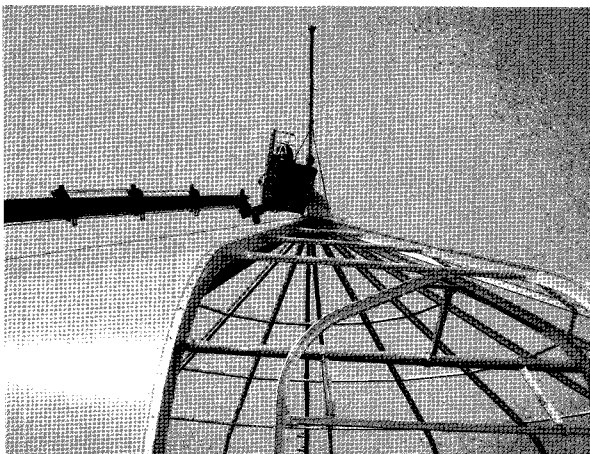
〈그림 22〉 골조 완성 후 첫번째 패널 막 설치모습
