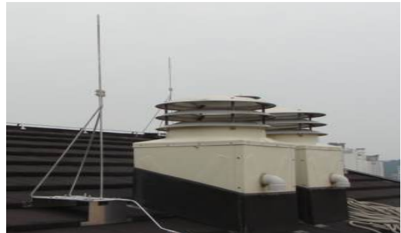
그림 14. 보조피뢰침의 시공 사례 Fig. 14. Picture of auxiliary air-termination system installed on the metal roof
