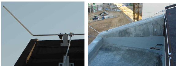
그림 12. 모서리 부분에서의 피뢰도선 시공 사례 Fig. 12. Picture of air-termination system installed at the corner
