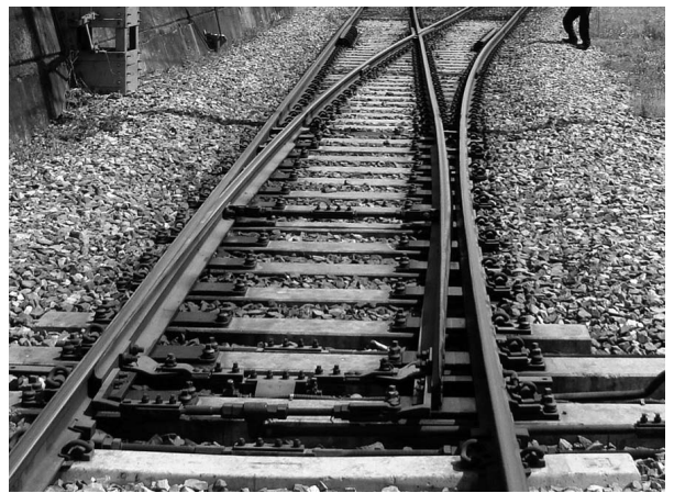
그림 1. 150kg PCT 선로변환장치
