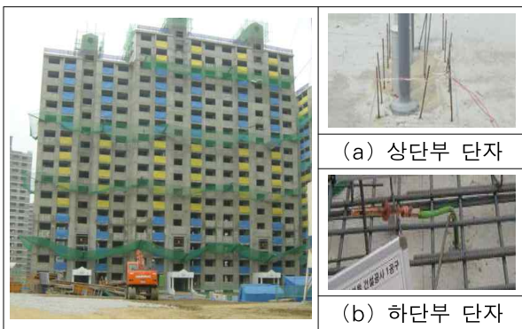
그림 2. 측정대상 철근콘크리트 아파트 일례 Fig. 2. Apartment for Resistance Measurement
