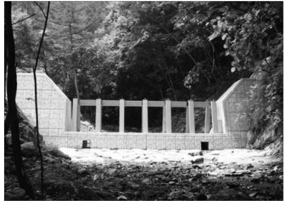
그림 4. 사방댐 (좌: 콘크리크사방댐, 우: 투과형사방댐(슬릿댐))
