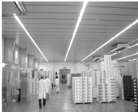
[그림 4] 적합한 천장 구조(중천장이 있어 먼지착상이 어렵고 청소가 용이함)
