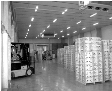
[그림 4] 적합한 천장 구조(중천장이 있어 먼지착상이 어렵고 청소가 용이함)
