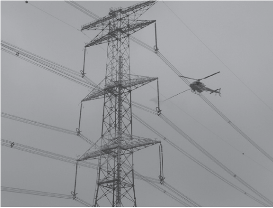
〈765kV 활선 애자청소〉
