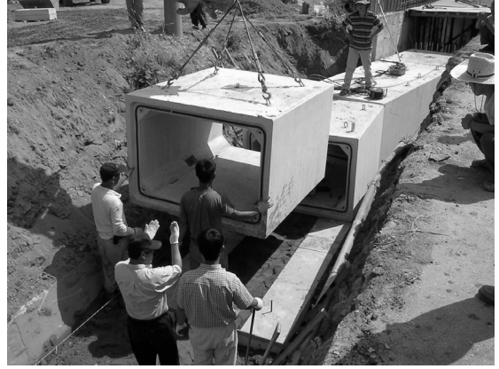
사진 2. RCS 암거를 기초판에 거치 시키는 모습
