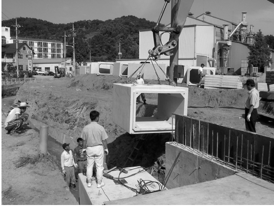
사진 1. 백호우를 이용하여 암거를 거치하는 모습
