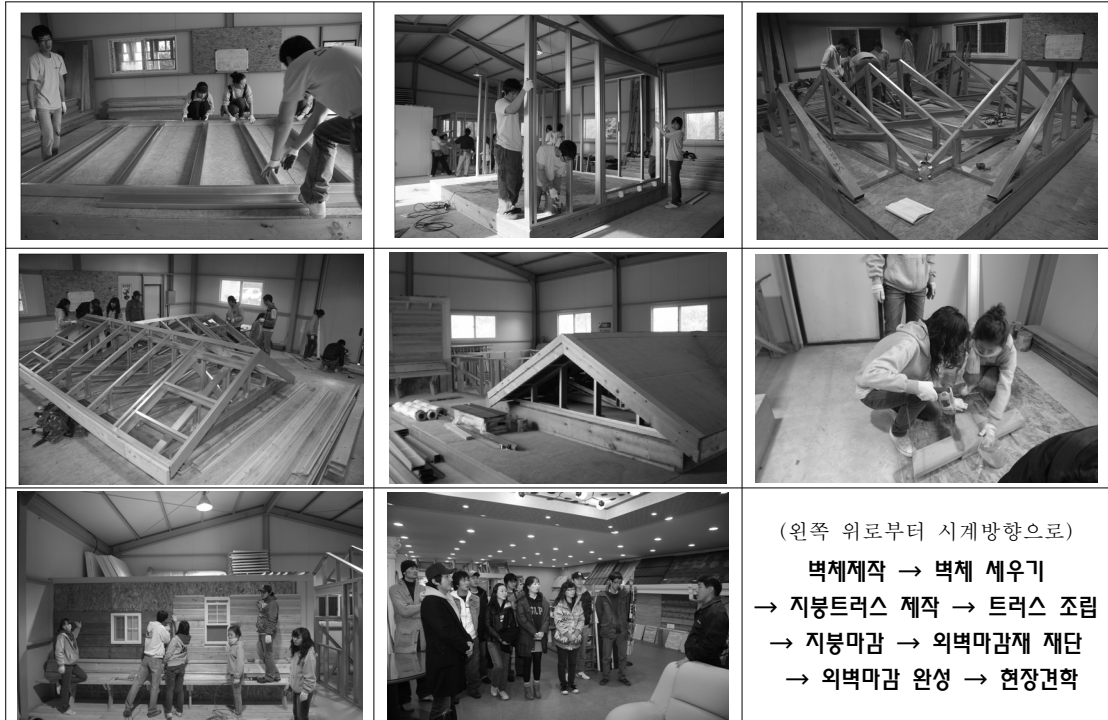
그림 9. 스틸하우스의 시공과정 실습장면 Fig. 9. Construction Process at workshop place
