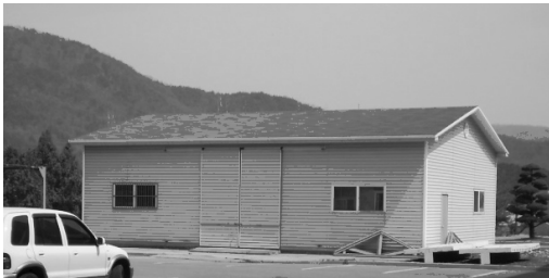
그림 5. 실습장 외부 (철골+샌드위치 패널+아스팔트 싱글) Fig. 5. Outer view of construction workshop place
