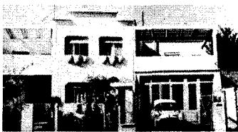
<그림 8> 르 꼬르뷔제, 페사크 주택, 1960년대, 거주자에 의해 분절되고 덧창 등 장식요소가 설치된 수평으로 긴 창
