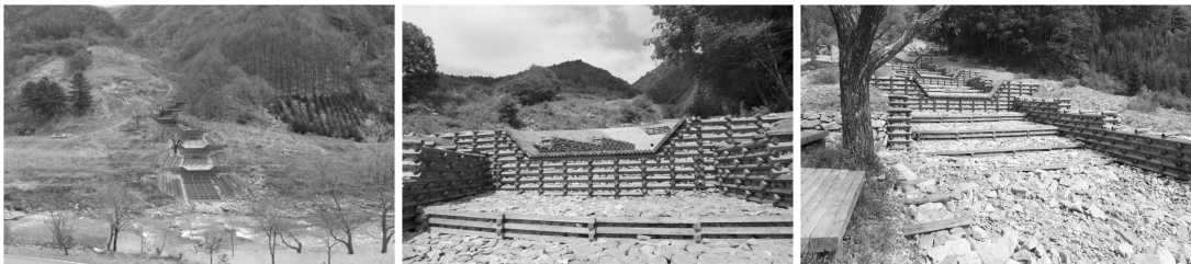
그림 5. 국산 간벌재를 이용한 토목구조물 시공 사례
