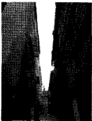
<그림 1> H사례 인접 건물 이격공간
