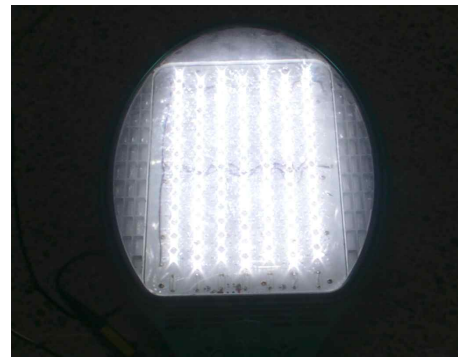
그림 18. 가로등용 LED 광원 동작 Fig. 18. Operation of Street light LED source
