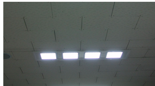
그림 4. LED 조명기구의 설치 모습
