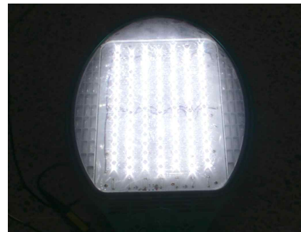
그림 17. 가로등용 LED 광원 동작 Fig. 17. Operation of Street light LED source
