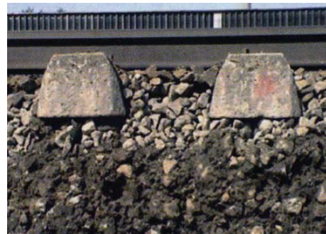
그림 1. 도상자갈의 변화 (직경 22.5mm이하 자갈 40%이상 흡입상태)
