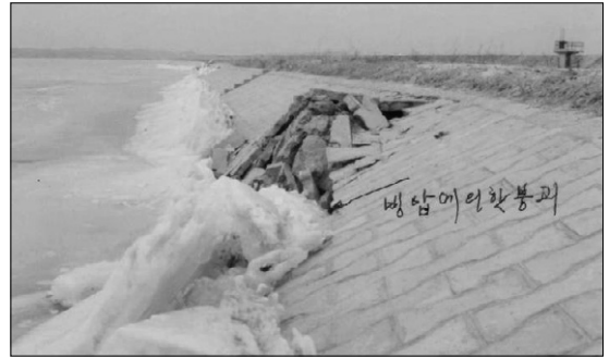
그림 3. 빙압에 의한 사면 보호공 붕괴
