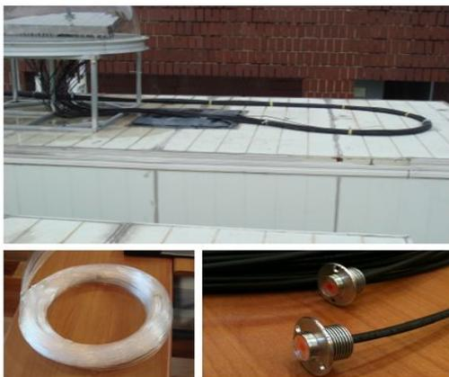
그림 3. CF POF 자연채광 시스템 전송부 전경
