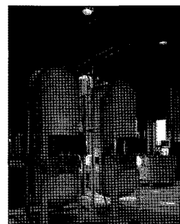
그림 10. 초전도케이블 냉각시스템.
