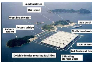
그림 2 Kamigoto oil Storage Base
