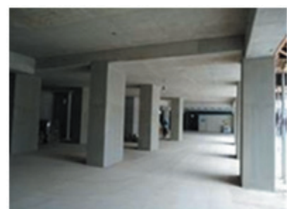
(f) Transfer Mat 타설 완료
