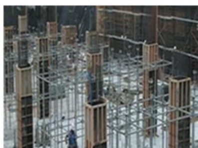
(d) 시스템 서포트 설치
