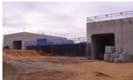
사진 9. 앵커리지 시공 현황
