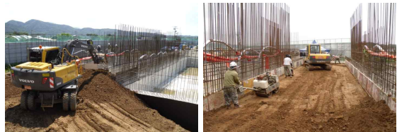
사진 7. 토사 채움 및 다짐
