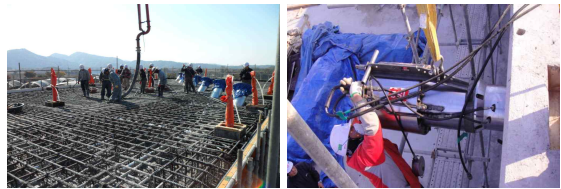
사진 8. 상부슬래브 타설 및 앵커리지 긴장력 도입
