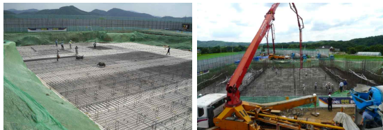
사진 4. 기초철근 배근 및 기초 콘크리트 타설
