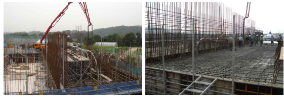
사진 6. 앵커리지 벽체 및 중간 슬래브 타설
