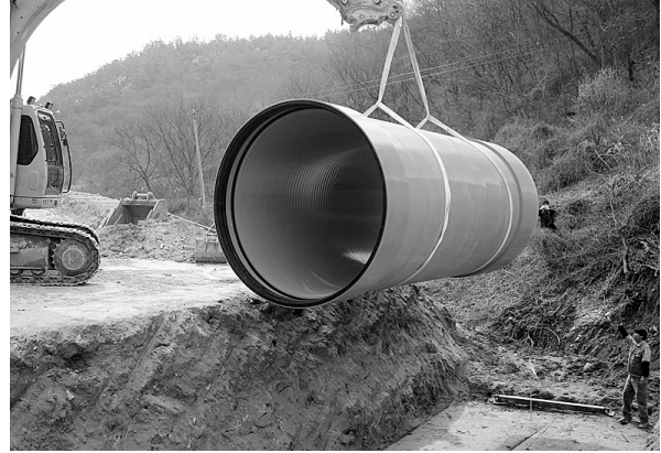
(b) 생활폐기물 매립 설치 공사(경남 함양)
