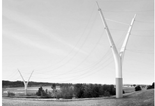
그림 4. Y자 형태로 제작된 FRP 송전탑 ( http://inhabitat.com )
