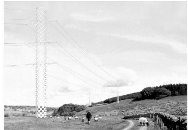
그림 5. 원통 형태로 제작된 FRP 송전탑 ( http://inhabitat.com )
