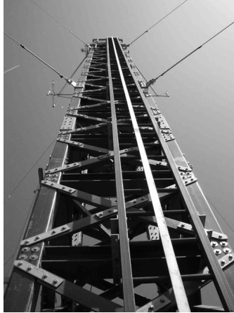
그림 2. 볼트 연결로 제작된 FRP 송전탑 ( http://www.compositesworld.com )
