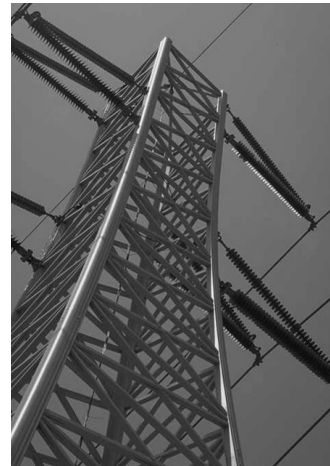
그림 1. 핸드레이업 연결로 제작된 FRP 송전탑 ( http://www.ebertcomposites.com )
