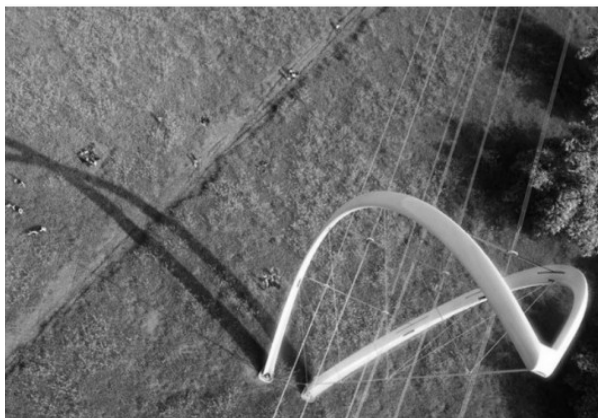
그림 3. 활 형태로 제작된 FRP 송전탑 ( http://inhabitat.com )
