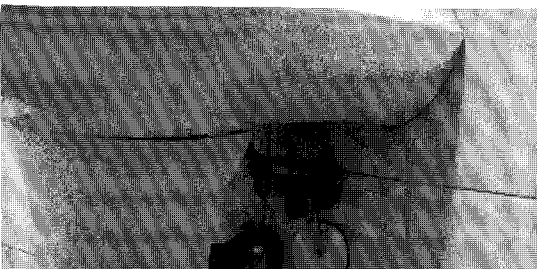
그림 13. 세면기 급수배관의 보조등전위본딩 사례
