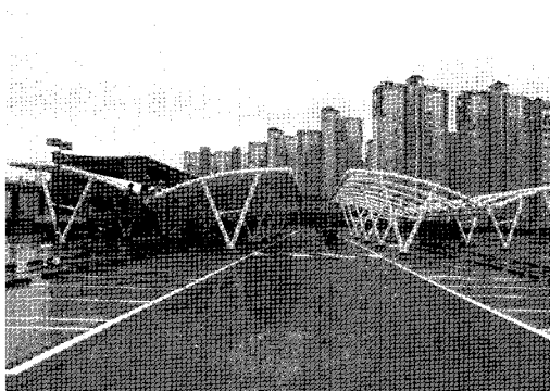
〈사진 10〉 A구간 지붕막 설치
