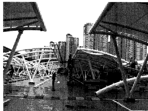
〈사진 12〉 B구간 지붕막 설치
