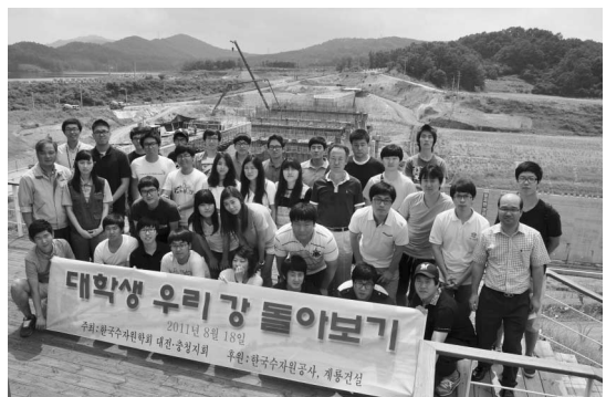
그림 2. 대청댐 비상여수로 공사현장(설명: 삼성 정명현 대리)
