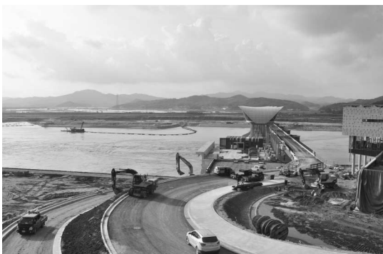
그림 4. 금강 살리기 6공구 공사현장(백제보)
