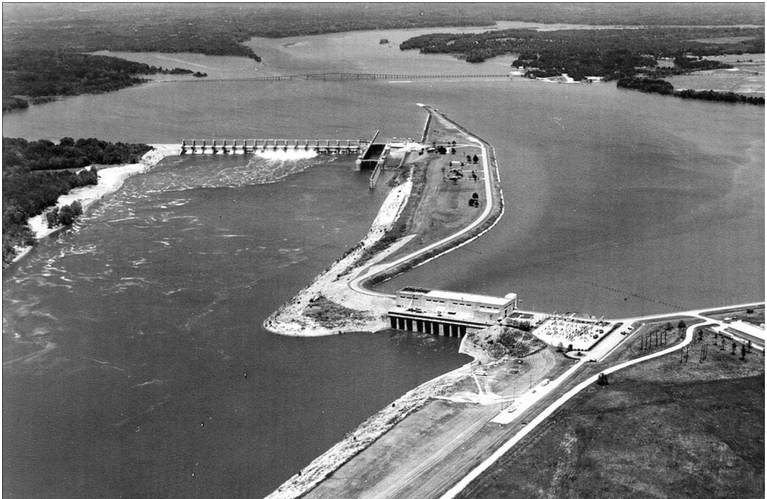
그림 4. Millers Ferry Lock and Dam
