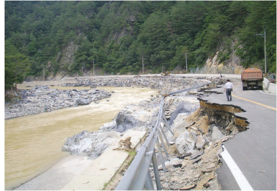
그림 2. 산지하천 만곡수충부의 편수위에 의한 도로피해(송천, 2006)
