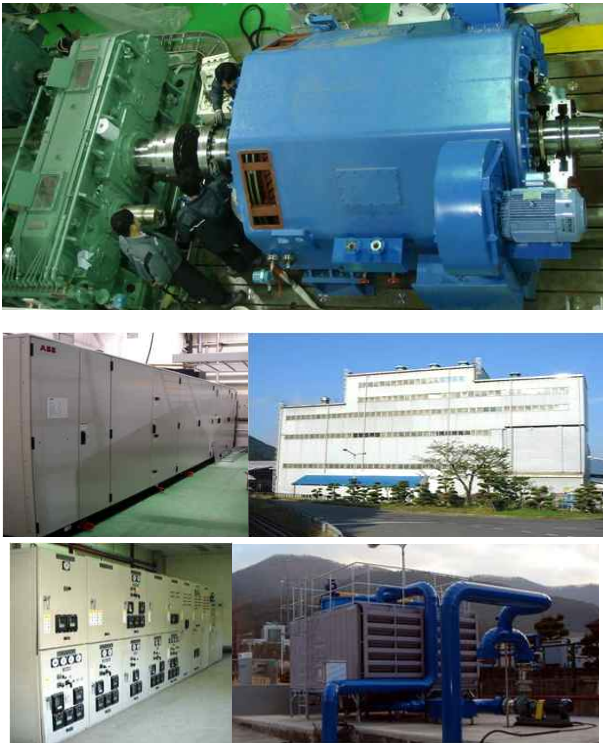
그림 2. 5MW급 초전도 전동기 부하시험 준비.
