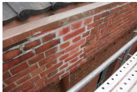
그림 9. 구서울구치소의 탄성형수지계 몰탈을 사용한 보수
