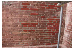
그림 1. 구서울구치소 시멘트바름 시공
