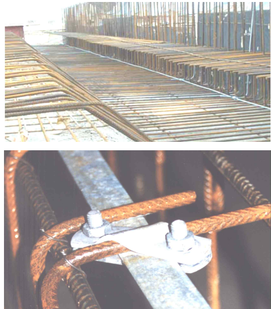
그림 6. 기초콘크리트접지 시공 사례 3)
